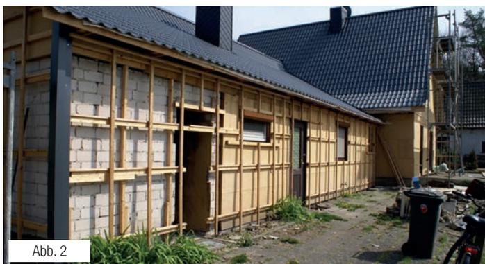
Nachdem Sie die Aufteilung in Montagefelder vorgenommen haben, beginnen Sie mit der Montage der Unterkonstruktion. Beachten Sie die Auflagebreiten und maximalen Unterkonstruktionsabstände für das Sinusprofil. Bei dem QuickPaneel darf der Unterkonstruktionsabstand (Riegelabstand) 600 mm nicht überschreiten.
