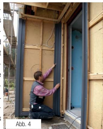
Als Nächstes setzen Sie die Außenecklisenen und gegebenenfalls die Innenecklisenen. Achten Sie darauf, dass die Montage aller Lisenen exakt lotrecht erfolgt.
