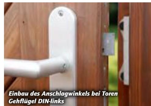
Einbau des Anschlagwinkels bei Toren
