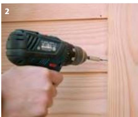
**2.** Fixieren Sie jedes Brett mit einer Schraube von 3,5 x 55 mm. Diese wird am unteren Ende des Jütland-Brettes gesetzt (siehe Foto). Die Schraube wird seitlich schräg in die Nut geschraubt.
