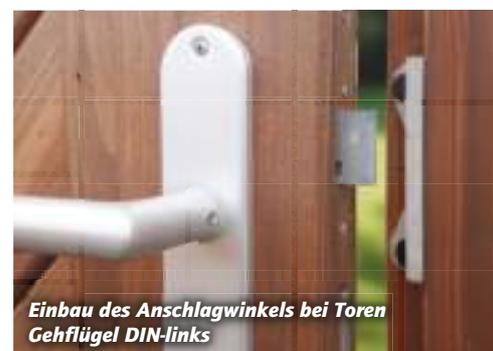
Einbau des Anschlagwinkels bei Toren
