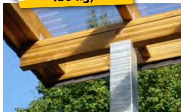
Sonderausführung mit Stahlpfosten
