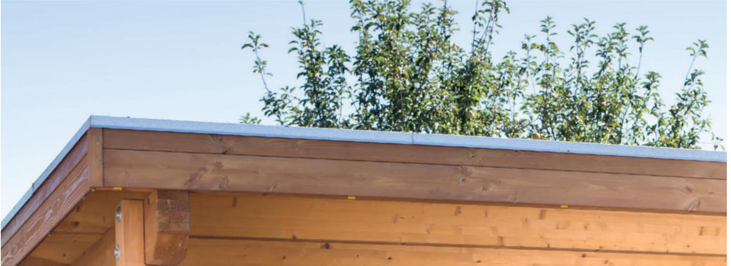
Konstruktiver Holzschutz rundherum. Hochwertige Aluminiumprofile schützen die Holzblende. Reines Aluminium → kein Rost. Serienmäßig bei Bitumendächern. Bei Alu-, Stahl-, Kunststoff-, EPDM- und Ökodächern als Ergänzung. Siehe folgende Tabelle.
