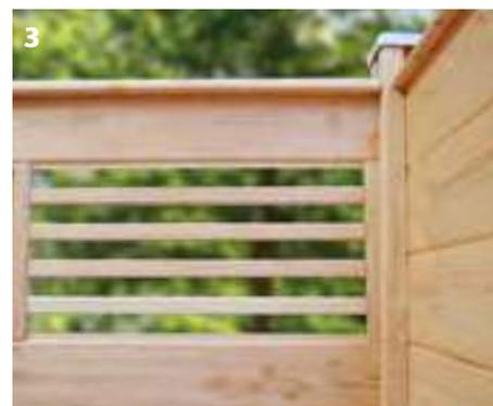
**3.** Der Gittereinsatz (optional) wird ebenfalls in die Nut geschoben. Drehen Sie das oberste Brett um, sodass die Feder nach unten zeigt und in die Nuten der Gitterleisten fasst. Hier wird beim obersten Brett nicht die Feder, sondern die Nut mit einem 2 cm breiten Streifen längs abgeschnitten. Die Pfostenköpfe werden mit einer Kappe geschützt.
