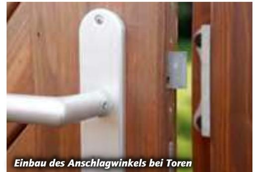
Einbau des Anschlagwinkels bei Toren
