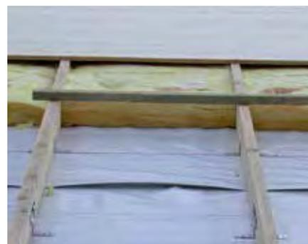
Das doppelschalige Dach für frostige Tage – zur Aufnahme der Dämmung vorbereitet
