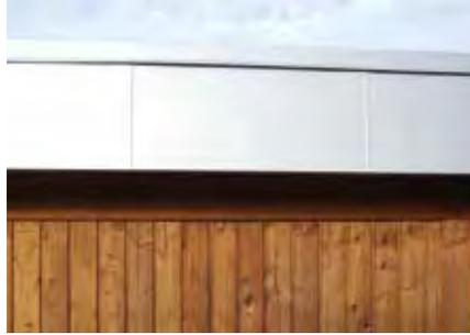
**Stirnbretteinfassung für Flachdach-Carports**, Stahlmetallic 045 Polyesterbeschichtung incl. Blindfalz, Eckprofil, Stirnbrettkappe und Montageschrauben; Länge: 615 mm
