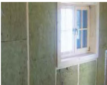
„Winterfest-Option“: doppelschalige Außenwand mit innenliegender Dämmung
