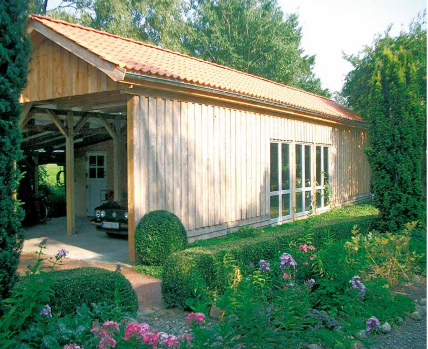
*Satteldach-Carportlösung mit individueller Wandgestaltung (sogenannter „Boden-Deckel-Schalung“)*
