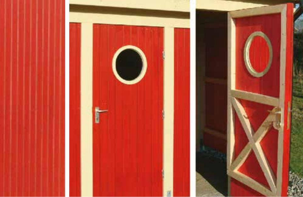
Massive Rahmenkonstruktion, außen mit Rundkanten-Profilbrettern (ca. 20mm) beplankt
