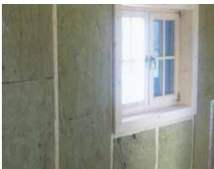
„Winterfest-Option“: doppelschalige Außenwand mit innenliegender Dämmung
