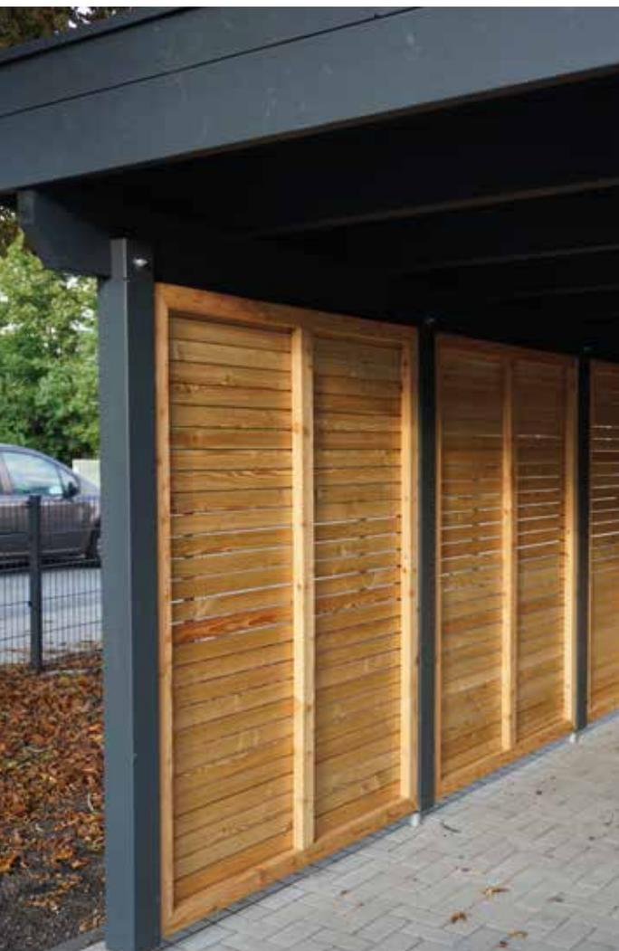
Seitenwand-Sonderelement: Rhombusprofil York, Sib. Lärche naturbelassen
