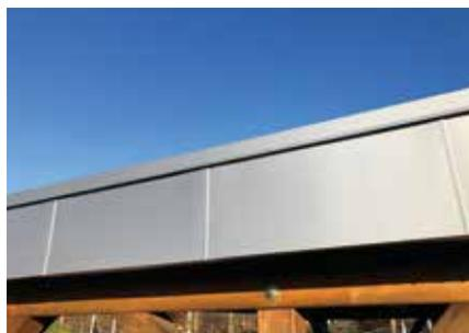
**1. Stirnbretteinfassung für Flachdach-Carports**, Stahlmetallic 045 Polyesterbeschichtung incl. Blindfalz, Eckprofil, Stirnbrettkappe und Montageschrauben; Länge: 615 mm
