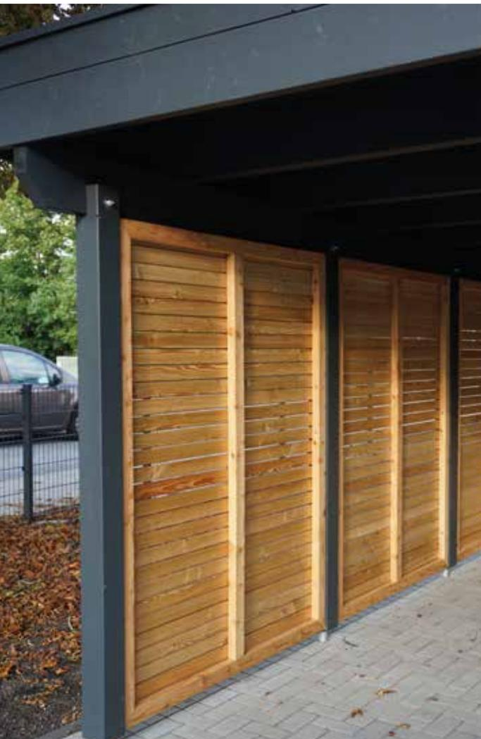
Seitenwand-Sonderelement: Rhombusprofil York, Sib. Lärche naturbelassen
