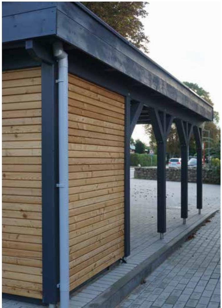
Rückwand-Sonderelement: Rhombus-Doppelprofil, Sib. Lärche naturbelassen
