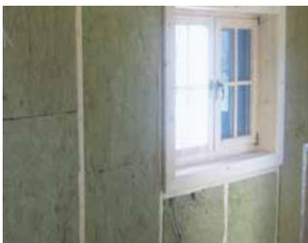
„Winterfest-Option“: doppelschalige Außenwand mit innenliegender Dämmung
