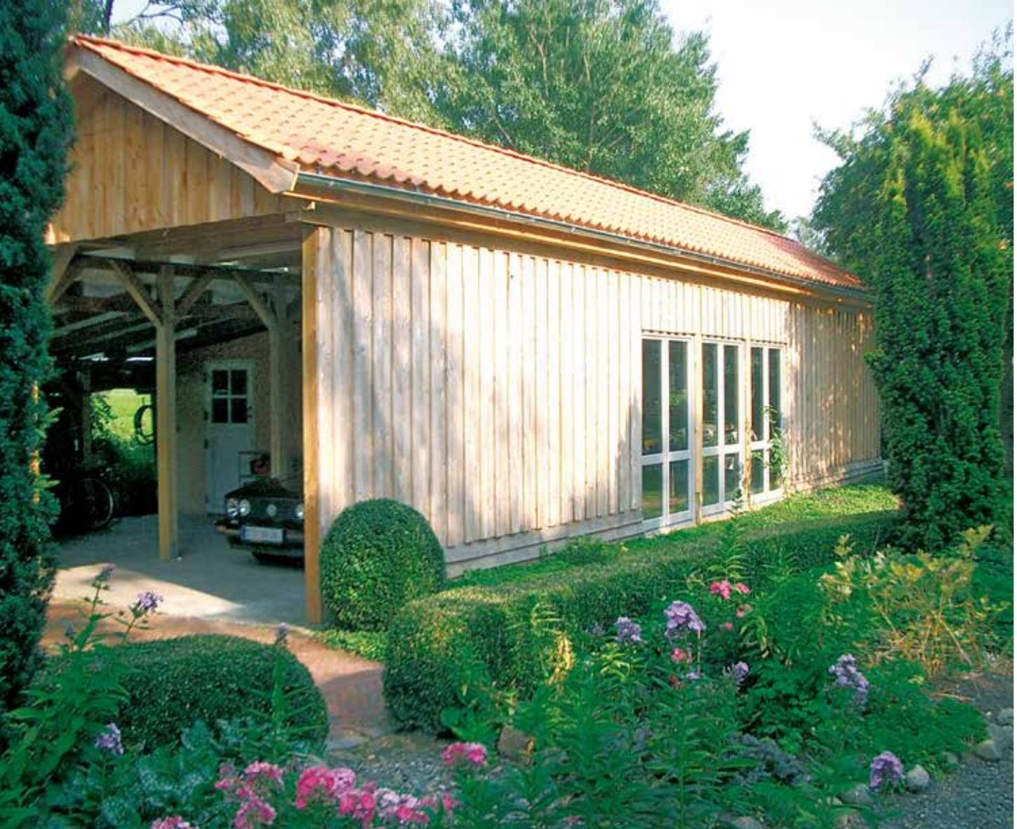
*Satteldach-Carportlösung mit individueller Wandgestaltung (sogenannter „Boden-Deckel-Schalung“)*
