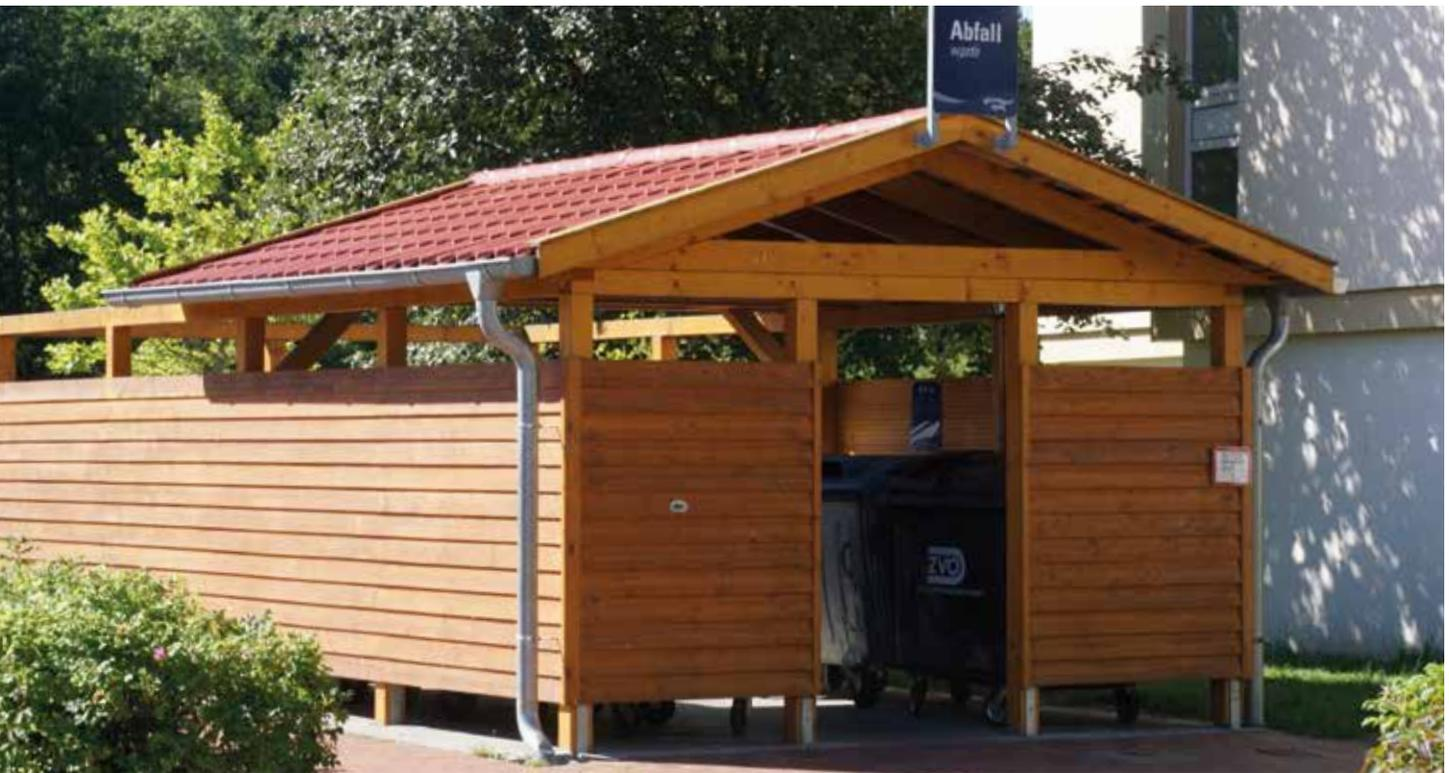
Unterstellplatz für Abfall, hier mit Wänden im Fassadenprofil N+F 28/15 x 141 mm, Lärche naturbelassen – Sondermodell
