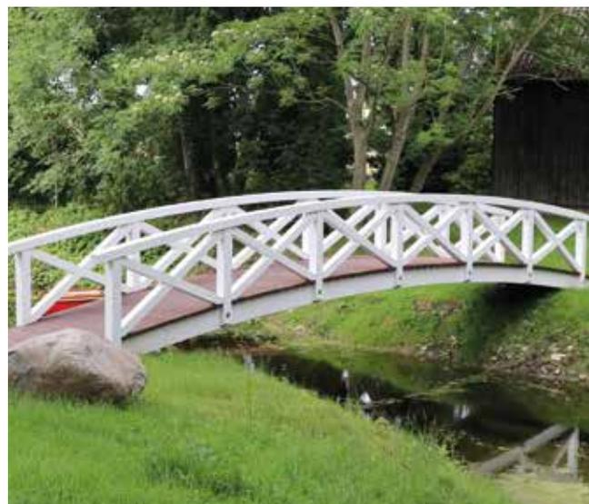
Spannweite ca. 10 m, Holz Ausführung Perfect Select, Fichte BSH/NSI, lichte Durchgangsbreite ca. 1,62 m, Brückenbelag bestehend aus Bangkirai Terrassendielen 38 x 145 mm
