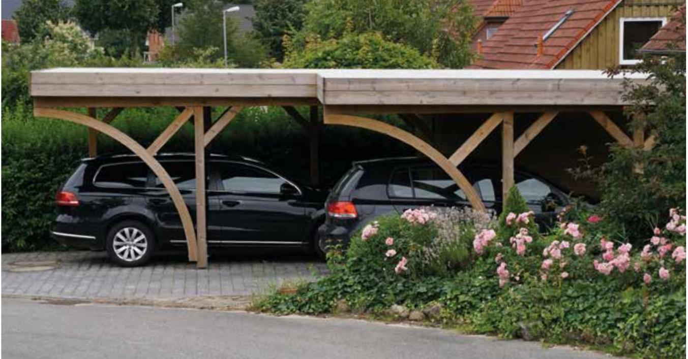
Als bewährte praktische Alternative zum herkömmlichen Pfosten bei engen Einfahrtsituationen. Pfostenbögen an einem Winkelcarport (Sondermodell). Inkl. verstärkter Konstruktion/geänderter Pfostenabstände. Lieferbar für Standard-Durchfahrtshöhe von 210 cm. Rechenbeispiel s. Tabelle rechts.
