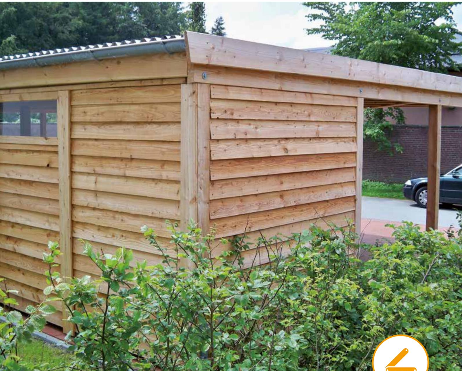
Belastbar: Verkleidung mit rustikalem Fassadenprofil. Abbildung zeigt Natur-Variante aus Lärche
