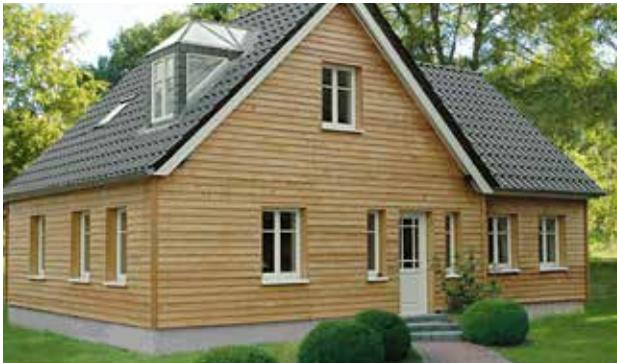
Fassaden-Gestaltung mit Fassadenprofil, Lärche naturbelassen
