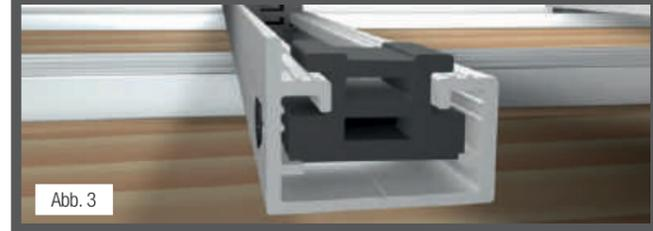
Die hohe Kante des Gleitprofils dient zur Stabilität der Kunststoffdachplatten. Es sollte aus optischen Gründen in die Hauptblickrichtung montiert werden.
