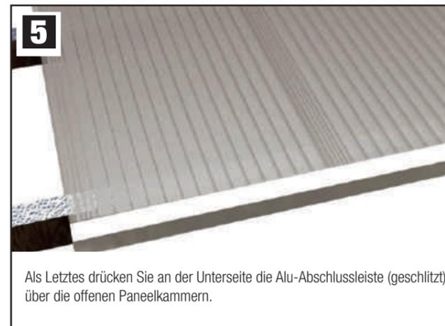
Als Letztes drücken Sie an der Unterseite die Alu-Abschlussleiste (geschlitzt) über die offenen Paneelkammern.
