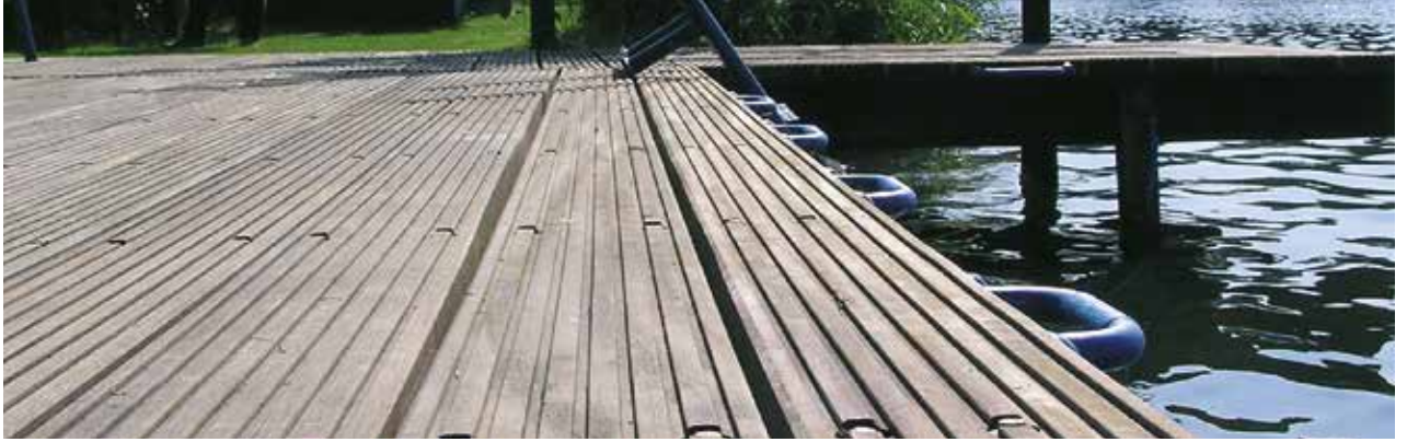
Unterkonstruktion im Wasser: Anwendungsbeispiel für Bongossi-Kantholz
