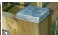
3 Metall-Abdeckplatte verzinkt
