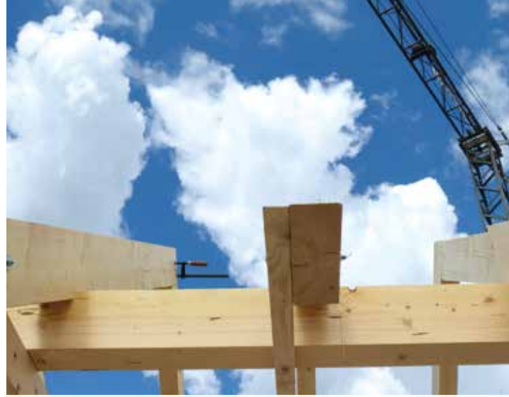
Ein Dachstuhl entsteht: Moderner Holzbau mit dem Naturbaustoff Fichte Leimholz SI
