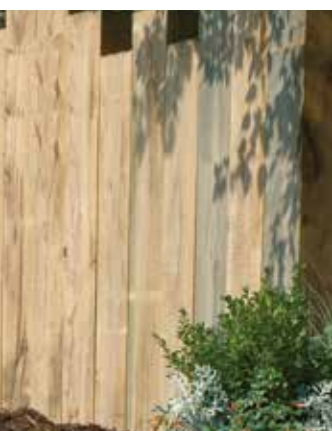
Kesseldruckimprägnierte Schwellen auch als Abgrenzung zur Terrasse
