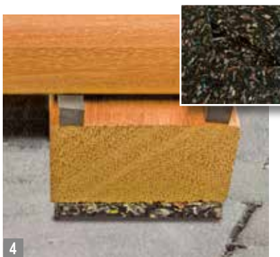
4 Gummi reguliert: Höhenausgleich-Pads für die Unterkonstruktion.
