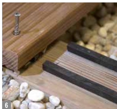
6 Praktisch: Selbstklebendes Ausgleichsband reguliert Unebenheiten.
