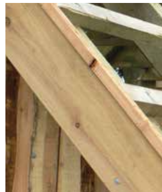
Lärchen – Dachstuhl im Detail
