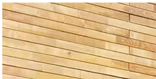
Rhombusprofil 21 x 60 mm
