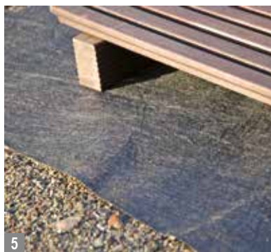
5 Wasserdurchlässiges Abdeckvlies gegen Durchwurzlung und Pfützenbildung.
