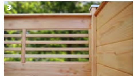
**3.** Der Gittereinsatz (optional) wird ebenfalls in die Nut geschoben. Drehen Sie das oberste Brett um, sodass die Feder nach unten zeigt und in die Nuten der Gitterleisten fasst. Hier wird beim obersten Brett nicht die Feder, sondern die Nut mit einem 2 cm breiten Streifen längs abgeschnitten. Die Pfostenköpfe werden mit einer Kappe geschützt.
