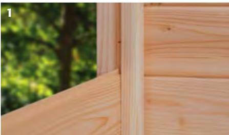
**1.** Die Zaunpfosten werden im Abstand von 177 cm (lichte Weite) gesetzt. Dabei müssen die Laschen der Pfostenanker nach vorne und hinten zeigen. Die Steckzaun-Bretter schieben Sie in die Nuten der Pfosten. Hierbei ist die Feder des Brettes nach oben gerichtet (Wasserablauf). Das unterste Brett sollte ca. 3 cm von der Pfostenunterkante beginnen.
