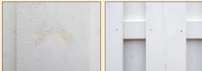
Auch hier verwenden wir eine stärkere Pigmentierung, die Holzstruktur bleibt aber vollständig sichtbar (Maserung, Äste sowie kleine Ausbrüche und Fehlstellen). Durch die dünne Schichtstärke können vereinzelt Holzinhaltstoffe auf die Oberfläche ausgetragen werden und gelbe Verfärbungen verursachen. Diese lassen sich ohne großen Aufwand (leichtes Anschleifen, dünner Farbauftrag) beseitigen.
