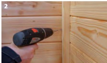
**2.** Fixieren Sie jedes Brett mittig mit einer Schraube von 3,2 x 40 mm. Diese werden seitlich schräg in die Nut geschraubt. Beim obersten Brett muss die Feder in einem Streifen von 2 cm abgeschnitten werden. Darauf kommt die Abdeckleiste. Diese ist mit 178,5 cm etwas länger. Einfach maßgerecht anpassen und von oben festschrauben (vorbohren).
