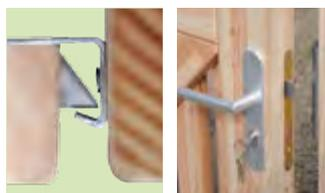
Anschlagwinkel von oben      Einbau Anschlagwinkel
