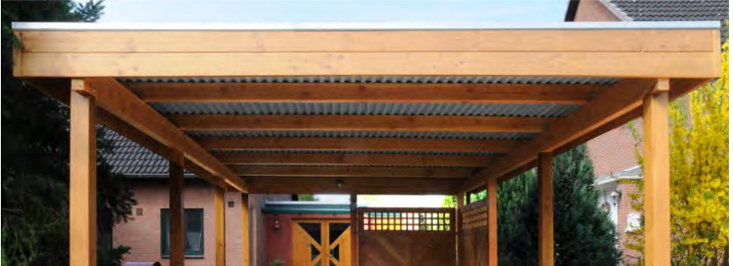
Konstruktiver Holzschutz rundherum. Hochwertige Aluminiumprofile schützen die Holzblende. Reines Aluminium → kein Rost. Serienmäßig bei Bitumendächern. Bei Alu-, Kunststoff-, EPDM- und Ökodächern als Ergänzung. Siehe folgende Tabelle.
