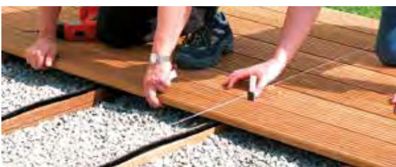
Lehre für gleiche Fugenabstände
