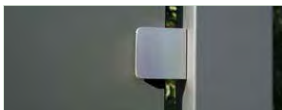
Detail-Ansicht zwischen Pfosten und Fassadenplatte HPL
