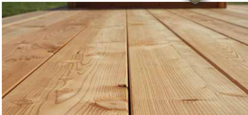
Detail-Ansicht Terrassendeck Gebirglärche
