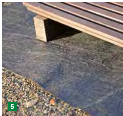
Wasserdurchlässiges Abdeckvlies gegen Durchwurzelung u. Pfützenbildung.
