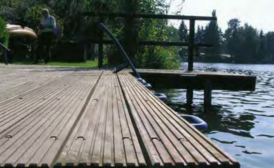
Unterkonstruktion im Wasser: Anwendungsbeispiel für Bongossi-Kantholz
