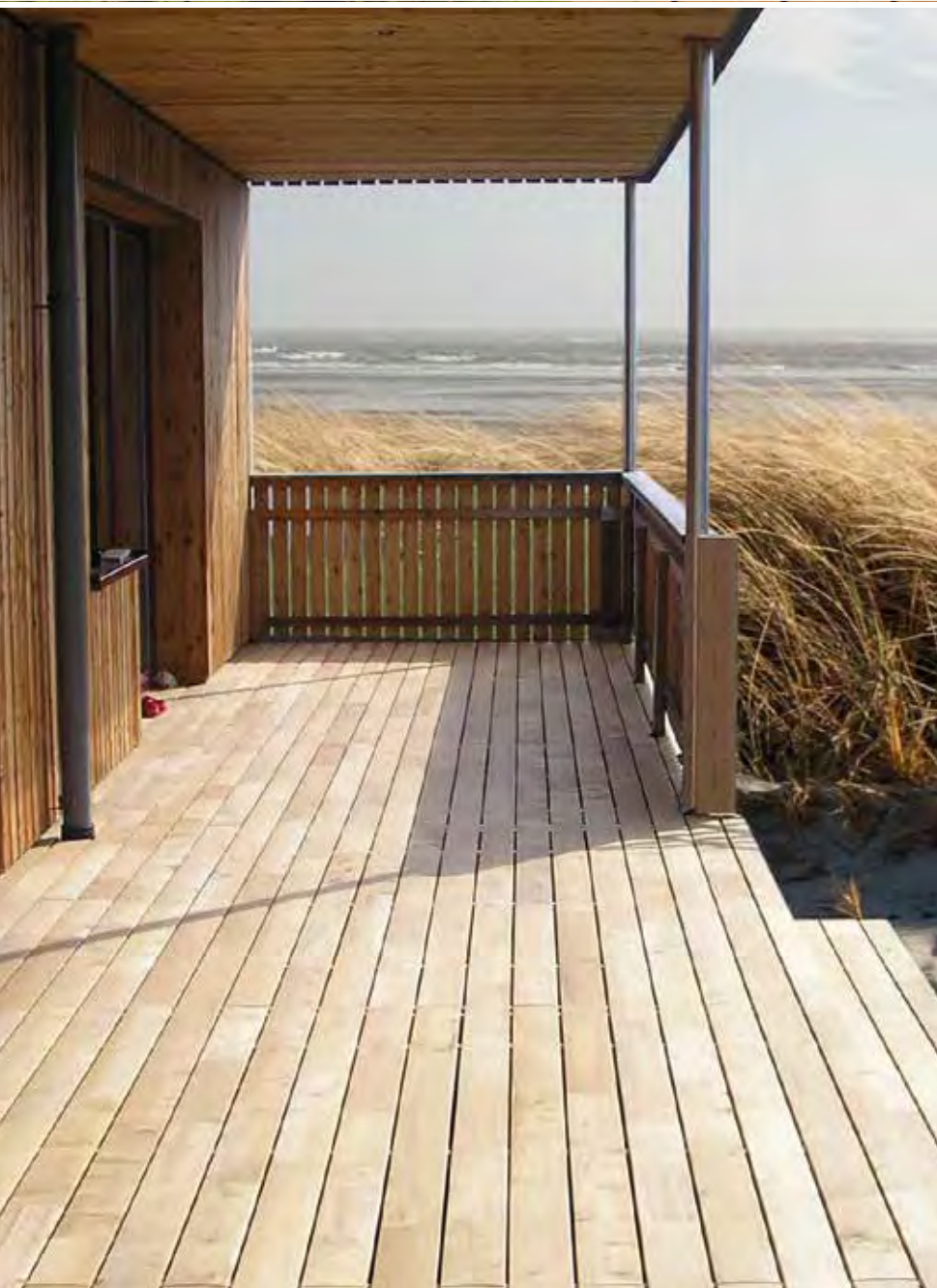
Bombiertes Terrassenprofil, Robinie naturbelassen
