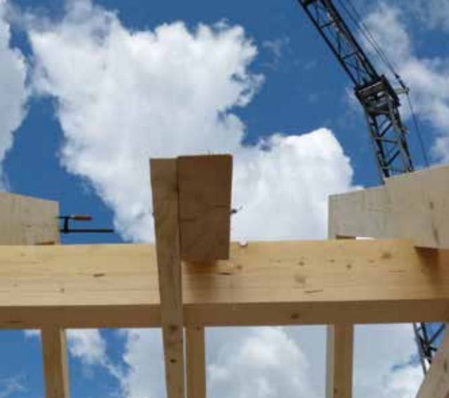
Ein Dachstuhl entsteht: Moderner Holzbau mit dem Naturbaustoff Fichte NSI
