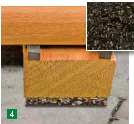
Gummi reguliert: Höhenausgleich-Pads für die Unterkonstruktion.
