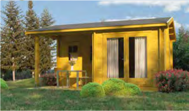
Mit Freisitz: Blockbohlenhaus „Gröndal“, bauseits farbbehandelt
