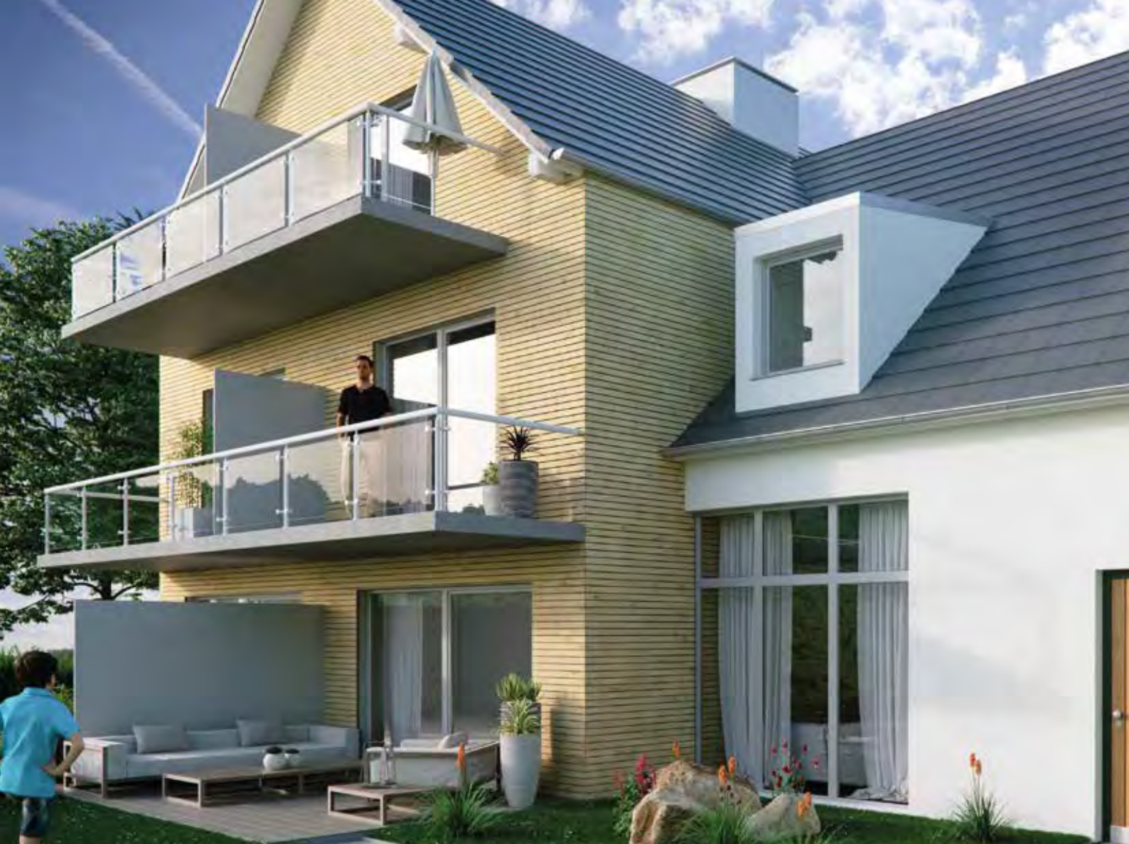
Fassaden-Verkleidung mit Rhombusprofil York, Sibirische Lärche naturbelassen
