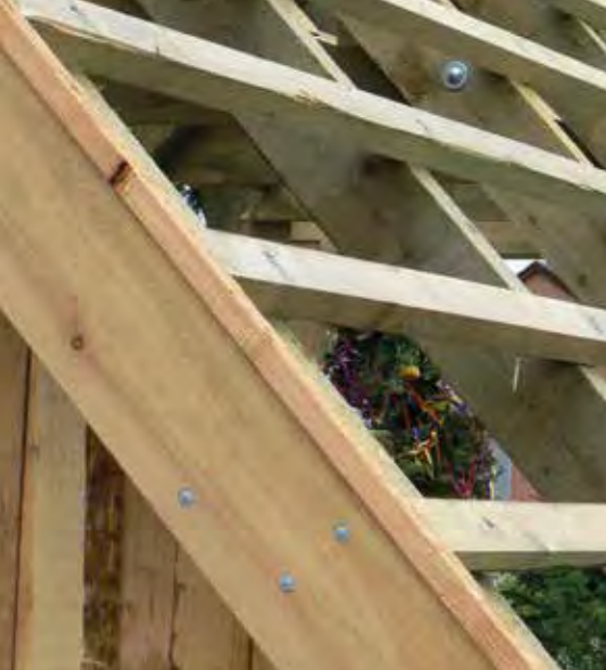
Lärche – Dachstuhl im Detail
